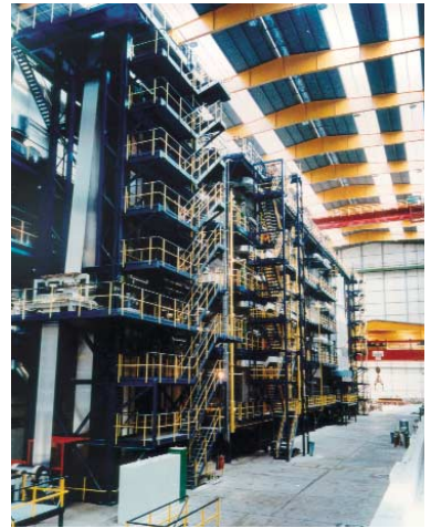
LOI Thermprocess entwickelt und fertigt große Industrieofenanlagen für das Erwärmen, Wärmebehandeln, Schmelzen und Gießen von Stahl und anderen Metallen.
